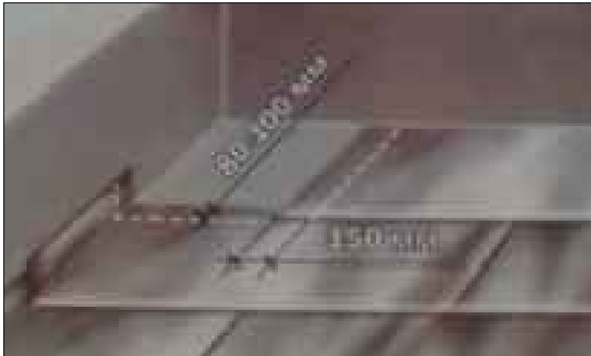
Рисунок 1 – Нахлест рулонного материала.
